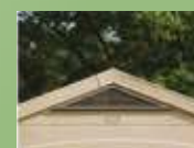
Fori di ventilazione
