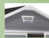
Fori di ventilazione
